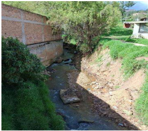
IMAGEN 04: SE MUESTRA LA QUEBRADA SAULLO REQUIERE DE INTERVENCION INMEDIATA CON MURO DE CONTENCIÓN CON LA FINALIDAD DE NO SEGUIR EROSIONANDO Y SOCAVANDO LOS TALUDES DE LA QUEBRADA
