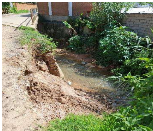
IMAGEN 03: SE MUESTRA LA QUEBRADA SAULLO PARA POR EL DISTRITO DE LLACANORA CON LAS MARGENNES EROSIONADAS Y REQUIERE DE LIMPIEZA.
